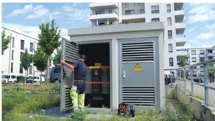
Die Trafostationen sind mit wartungsarmen Türzylindern ausgestattet, die bei nachlassender Batterieleistung mit aktiven blueSmart Schlüsseln bedient werden können
