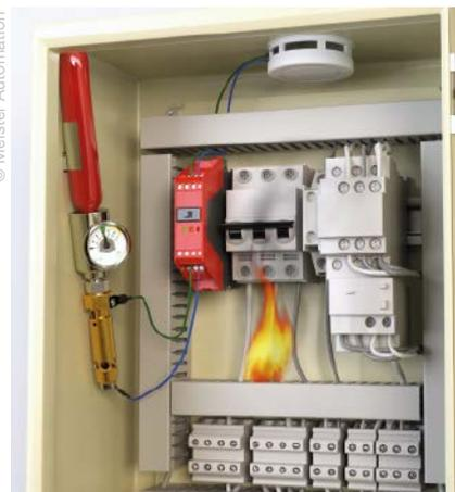
Automatische Mini-Feuerlösch-Einheit AMFE von Meister Automation
