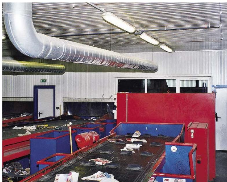
**In der Sortieranlage Achern wurden sechs Ansaugrauchmelder mit 500 Meter Ansaugleitung aus PVC installiert**
