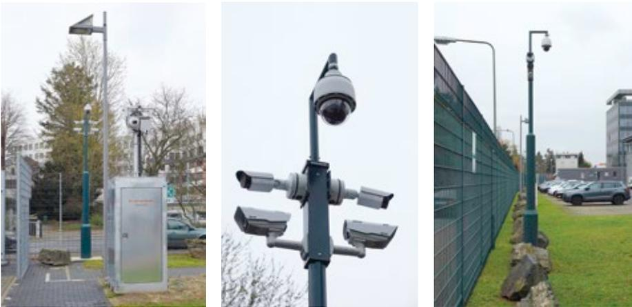
Hochauflösende Kameras, Systeme mit künstlicher Intelligenz und Thermalkameras sichern die e-shelter Rechenzentren
