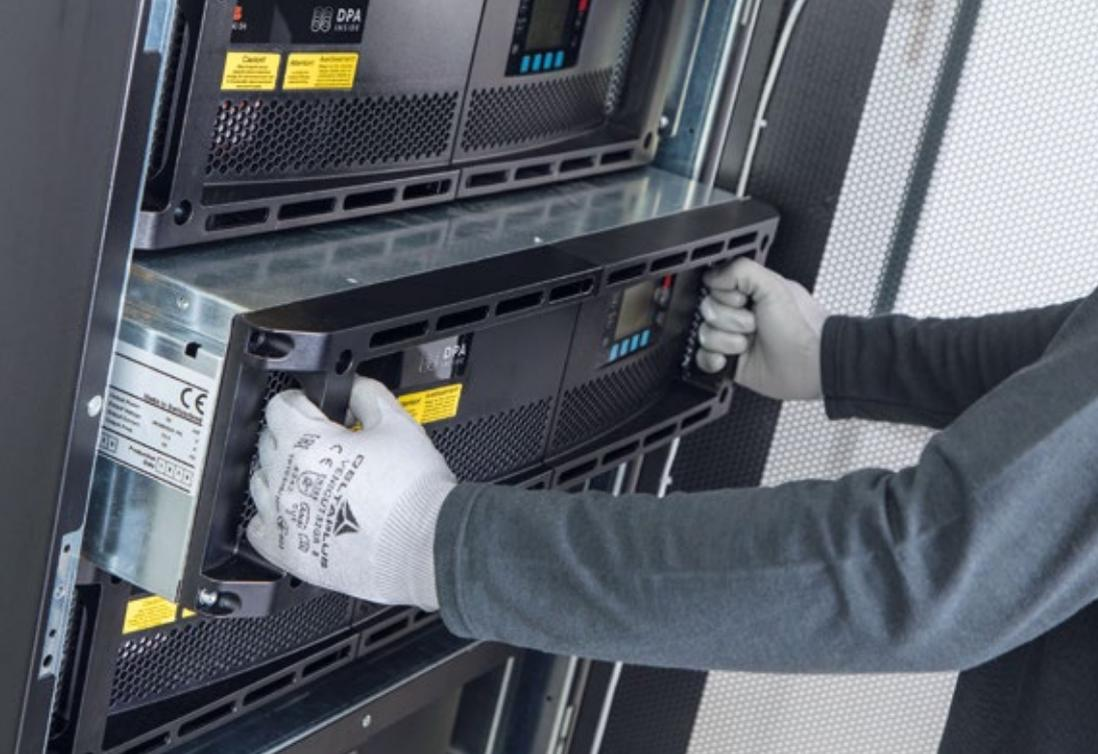
◀ Mit intelligenten und sicheren Stromanschlüssen können die DPA 250 S4-Module online getauscht werden, während die übrigen USV-Module im System die Last schützen, was die Wartung beschleunigt und vereinfacht
