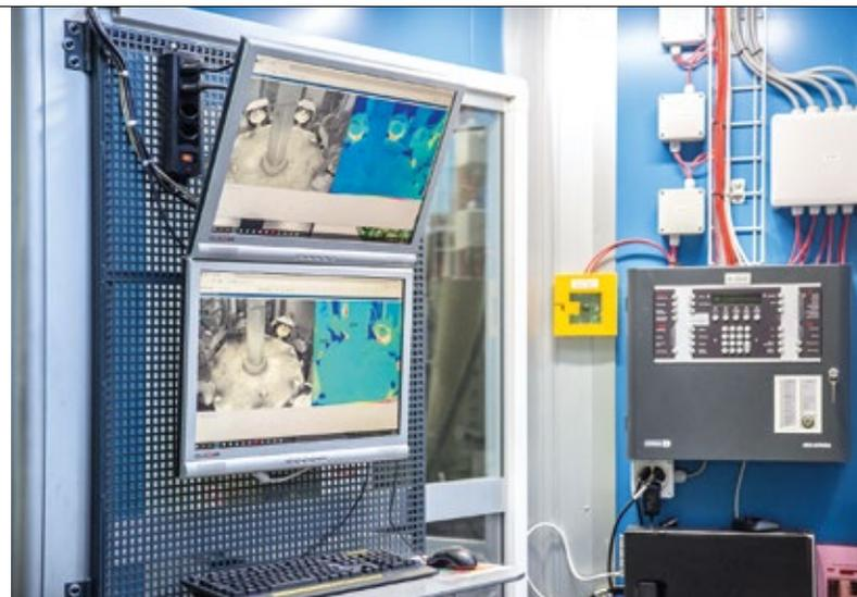
▲ Drei Eskalationsstufen wurden programmiert: Eine Warnmeldung bei einer kritischen Temperatur, den Produktionsstopp, wenn diese Grenze überschritten wird sowie den sofortigen Start des Löschvorgangs nach dem Produktionsstopp
