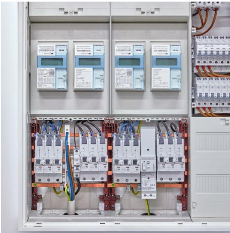
Flashtrab-SEC-ZP (unten rechts) ist das schmalste SPD Typ 1 für die Stromsammelschiene – es kann gemeinsam mit zwei SLS-Schaltern installiert werden
