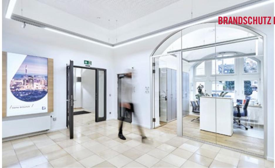
**Die Brandschutztüren müssen bei Bedarf offen gehalten werden können. Mit den Funkfeststellanlagen von Geze mussten für die zusätzlichen Decken-Rauchmelder, die durch die hohen Räume erforderlich wurden, keine Wände für Kabel aufgeschlagen werden.**
