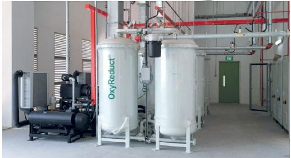
Oxyreduct reduziert den Sauerstoffgehalt im 76.000 m<sup>3</sup> Hochregallager, damit sich ein Brand gar nicht erst ausbreiten oder entwickeln kann. Die VPSA-Technologie gewinnt den Stickstoff für die Sauerstoffreduktion im geschützten Bereich
