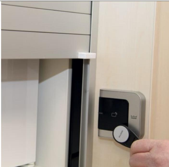
Leser installiert. Nur ausgewählte Pflegekräfte haben hier Zugriffsrechte. Zusätzlich wurden Magnetschnapper an den Schranktüren montiert. Diese sorgen dafür, dass sich die Türen bei Stromausfall öffnen.
