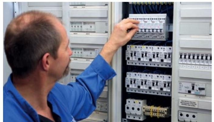
Der Brandschutzschalter 5SM6 identifiziert serielle Fehlerlichtbögen in der Elektroinstallation.
