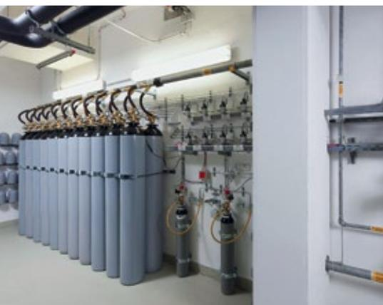
**Bereit für den Einsatz: Stickstoffbehälter für die Gaslöschanlage eines Rechenzentrums**
