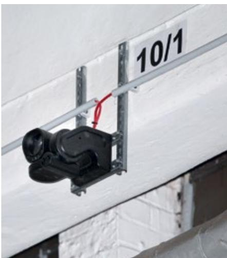
Sender und Empfänger der linienförmigen Rauchmelder ILIA wurden in den Produktionshallen unterhalb der Wärmepolster installiert
