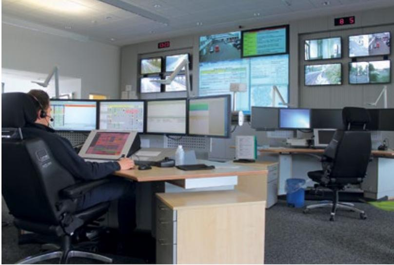
Aktuelle Tages- und Einsatzinformationen sowie Übersichtskarten auf einer Videowandinstallation von Eyevis: Sie besteht aus Rückprojektions-Cubes, flankiert auf beiden Seiten von jeweils vier LCDs
