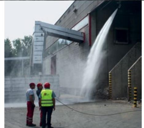
Die Löschwerfer lassen sich auch manuell über eine Joystick-Fernsteuerung bedienen
