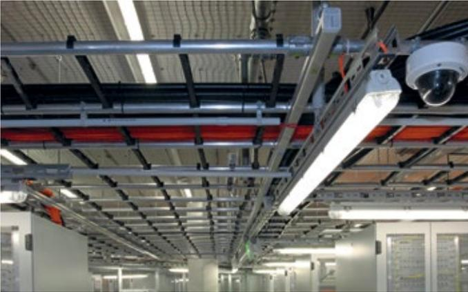
Gitterrost zur Aufnahme der Verkabelung im Rechneraum – sicherheitssensible Bereiche werden ständig videoüberwacht
