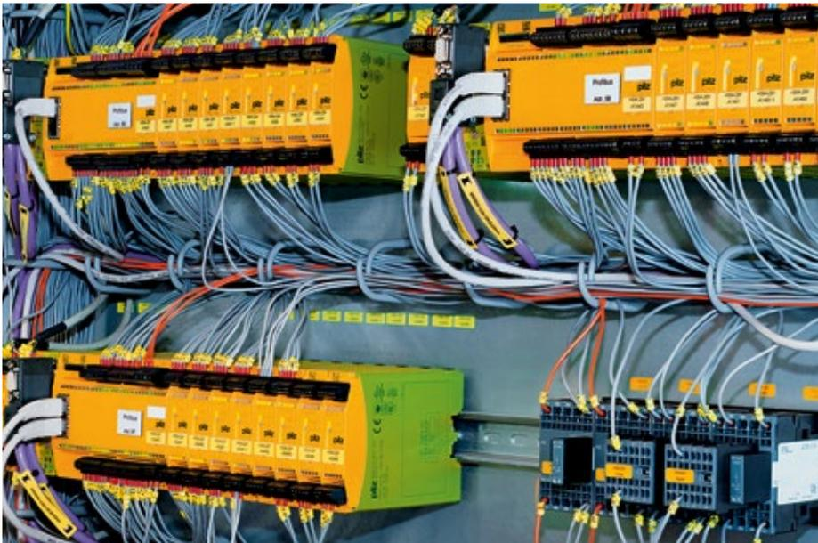
Als zentrale Sicherheitsinstanz überwacht das konfigurierbare Steuerungssystem PNOZmulti von Pilz sämtliche sicherheitsrelevanten Signale der Not-Halt-Taster, Schutztürsysteme und Zustimmungstaster
