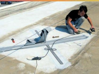
Der Anschlagpunkt von ABS Safety setzt auf eine neuartige Befestigungsmöglichkeit. Speziell für den Einsatz auf Bitumen- oder Kunststoff-Foliendächern entwickelt, muss der ABS-Lock OnTop weder mit zusätzlichen Gewichten
