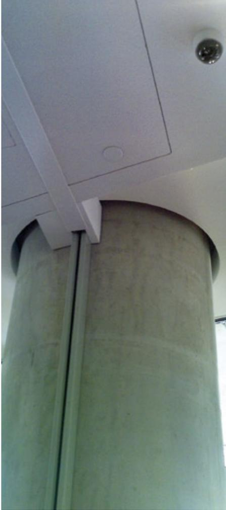
„Unsichtbarer“ Brandschutz - erkennbare Oberflächen der Abschlussleisten und notwendiger Führungsschienen wurden farblich angepasst
