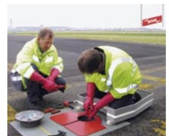
flächen. Zwei austauschbare Kniekissen sorgen für komfortables Arbeiten. Die wechselbaren Gleitkufen erlauben eine gute Positionierung und einen leichten Transport der Isolierwanne.
