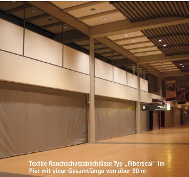
Textile Rauchschutzabschlüsse Typ „Fiberseal“ im Pier mit einer Gesamtlänge von über 90 m
